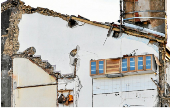
Reste d'habitation sur façade d'immeuble après démolition
